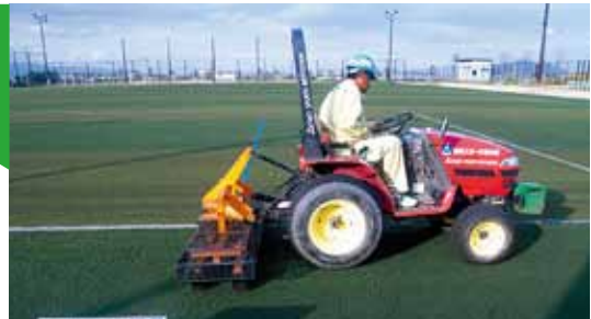
イントゥパイプブラシ(ジグザグブラシ)でブラッシング整正を行い、毛先を立てさせて整える
