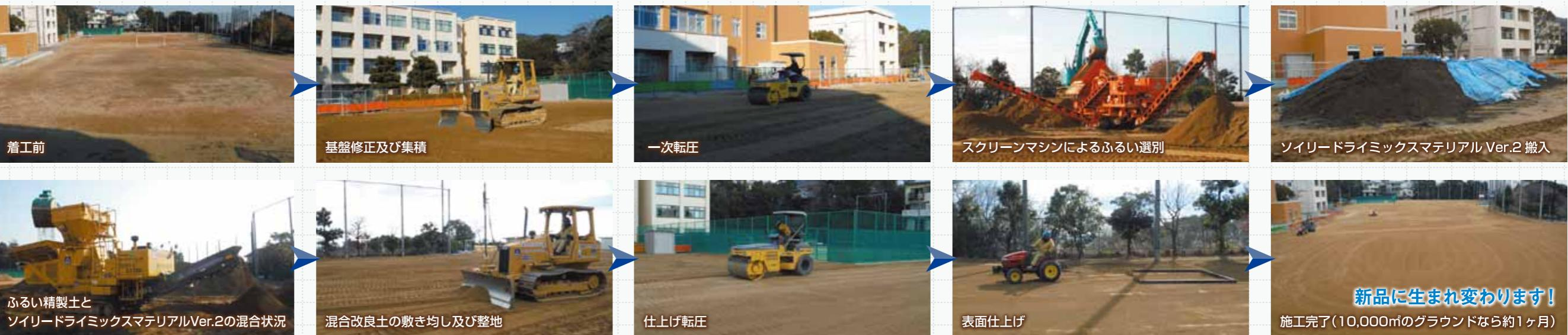
これまで一旦鋤取った土を他の場所にダンプで搬出し、外部で土壤改良材と混合した後にダンプで小運搬するので、近隣に粉塵と騒音を撒き散らしながら基盤を傷めて作業するか、グラウンド全体を使って定置式プラントを持ち込み、現場をダンプが走り回り基盤を傷めながら作業をするのが従来の工法でした。これでは舗装精度がいい加減になります。ソイリー・G工法Ver.2は土を外部に搬出することなく、現場でふるいから混合を2台の自走式機械で行いますので、基盤を傷めることがありません。しかも従来問題とされてきた狭い場所での施工にもマッチングさせることができ、様々なメリットを産み出しています。
