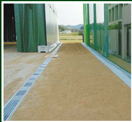
■ 排水設備の施工
